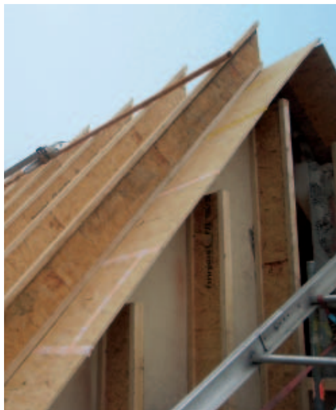
Mit Finnjoist zum gewünschten Dämmstandard sanieren.
