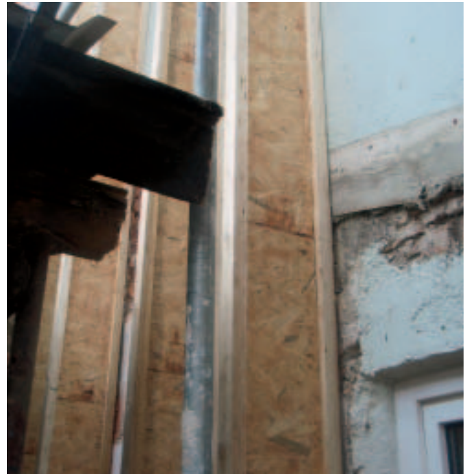
Die Finnjoist Träger werden nahtlos an der Wand, z. B. mit einem Dübelsystem oder Finntec, angebracht und bilden die Dämmebene. Weitere Informationen finden Sie auf www.finnjoist.de .
