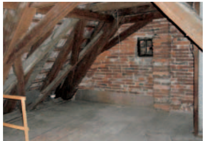
Dachstuhl im unsanierten Zustand.
