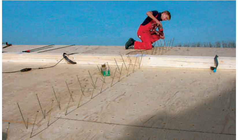
Aufgeschraubtes Kantholz mit Hebegurten
