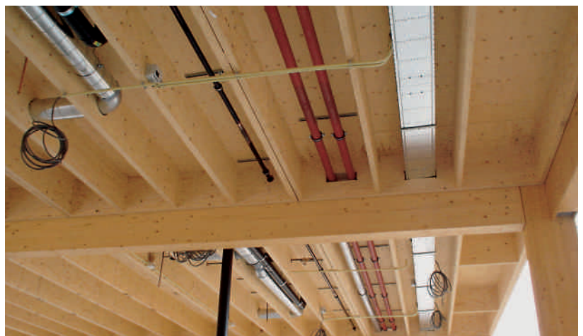
Beispiel für Leitungsdurchbrüche bei Rippenelementen
