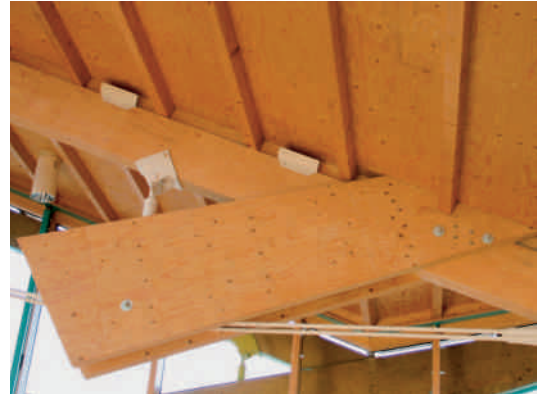
Dachbinder (Grundschule Aichach-Nord)
