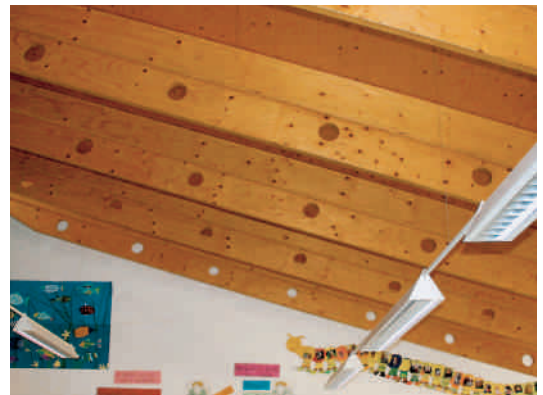
Dachbinder (Grundschule Aichach-Nord)
