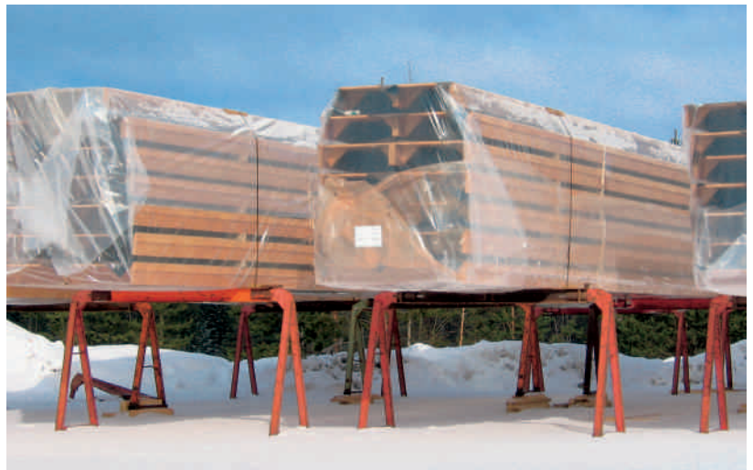
Transportfertige und mit Folie geschützte Rippenelemente
