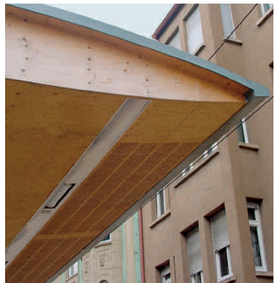
Akustikelemente (Stuttgart, Hölderlinplatz)
