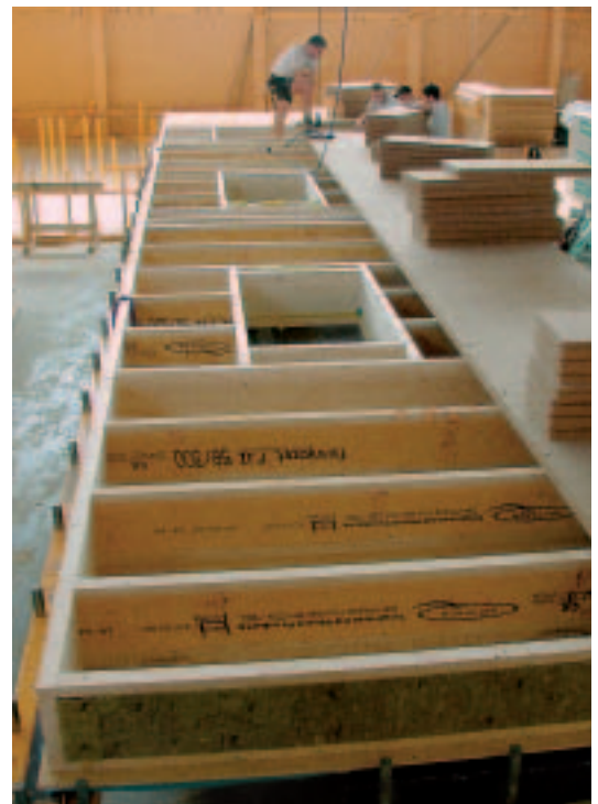
Hoher Vorfertigungsgrad der Elemente
