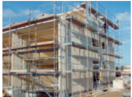
Rohbau Reihenhäuser in Darmstadt
