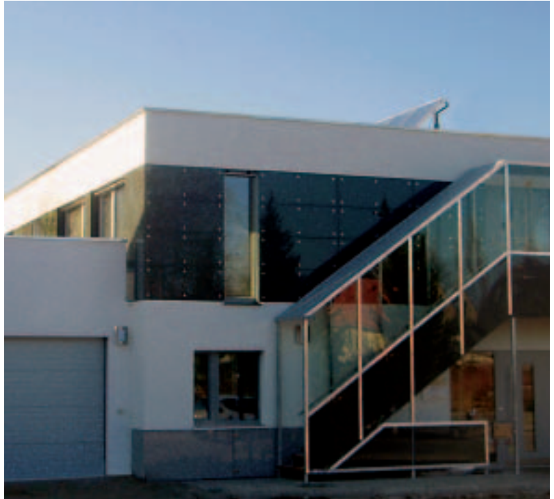
Wohn- und Gewerbenutzung in Augsburg – Baufertigstellung in 6 Wochen
