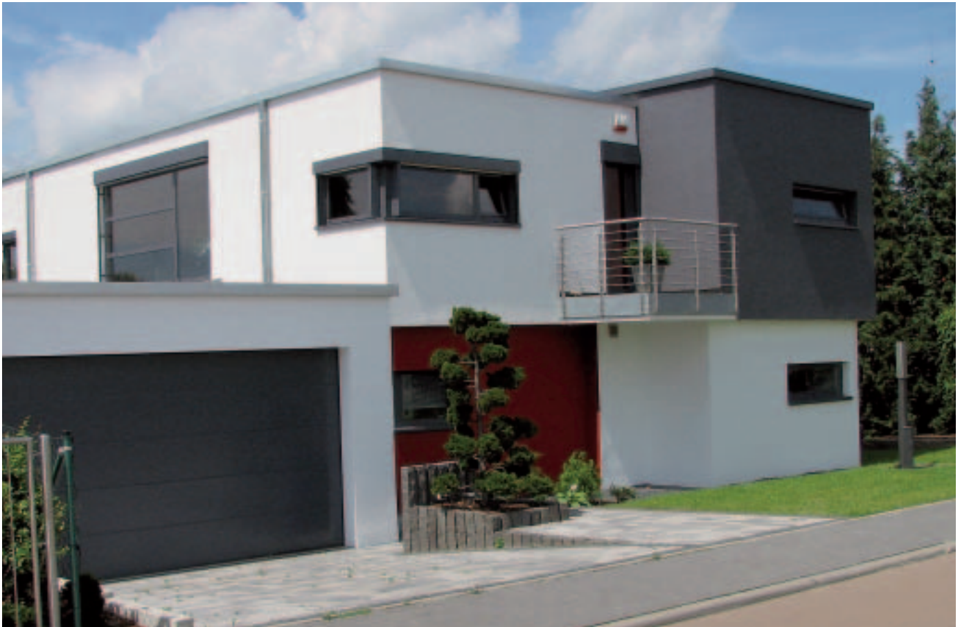
Wohnhaus in Idstein-Walsdorf
