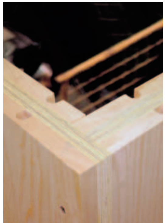
„KERTO in LENO“ luftdichter Anschluss der Außenwanddecke
