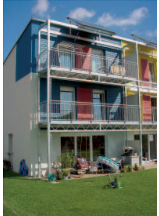
Passivhaus-Wohnanlage in Darmstadt
