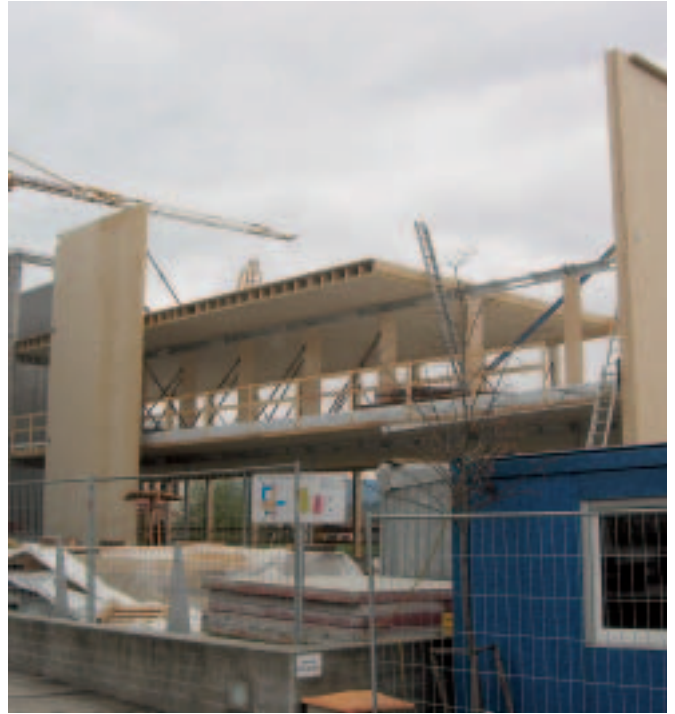
Hohlkasten-Deckenelemente, Fachhochschule in Salzburg
