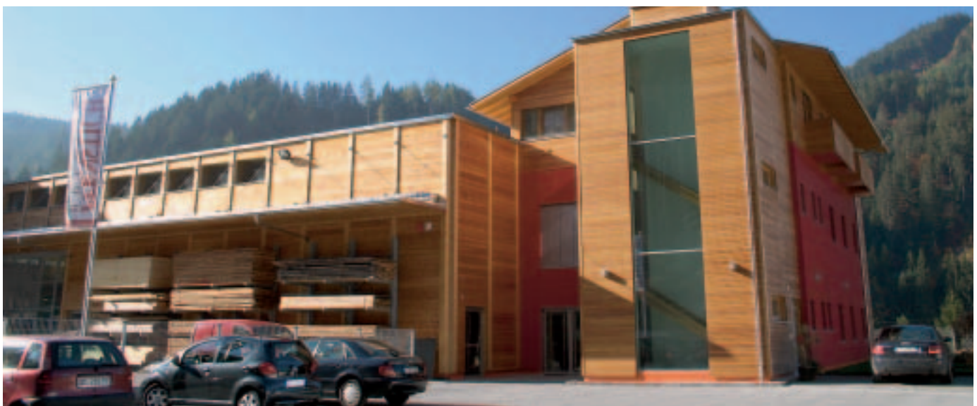
Industriehalle „Lignotec“ in Südtirol
