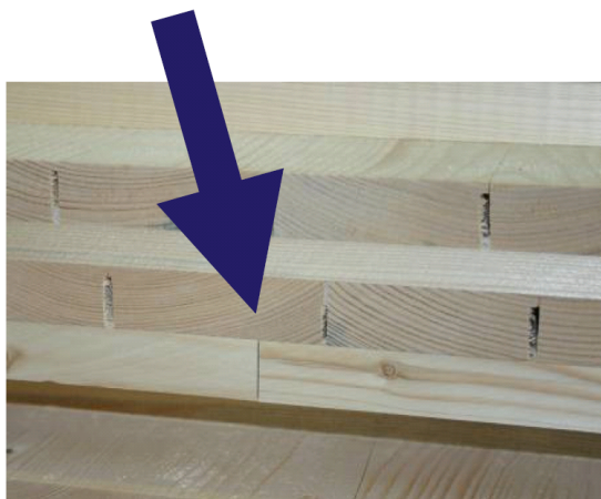
Abbildung 4: Stoß der Massivholzplatte
